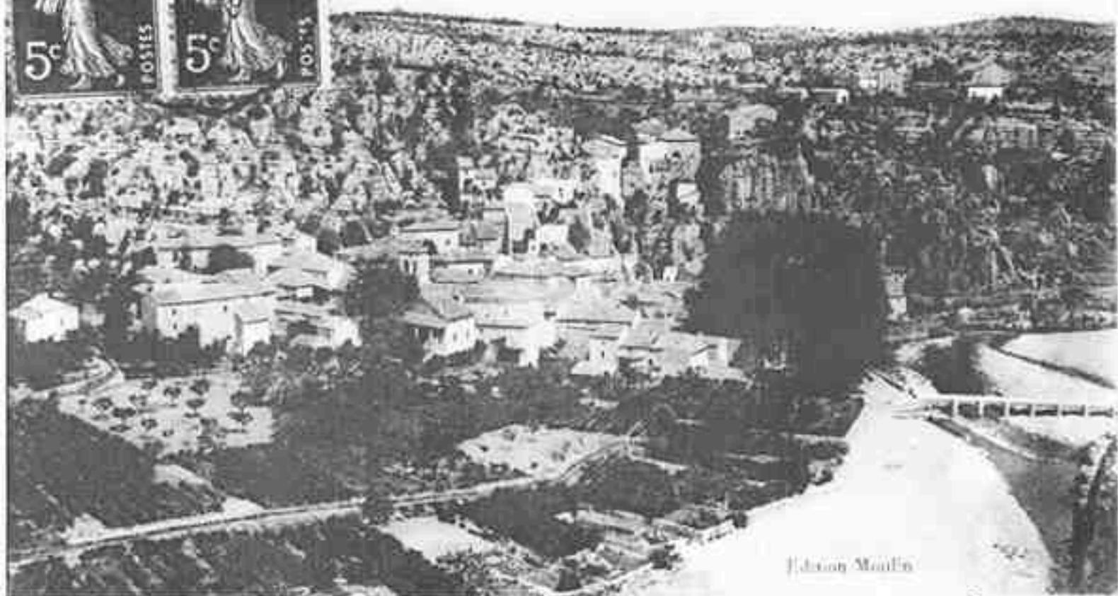
LABERUME. — Vue générale
